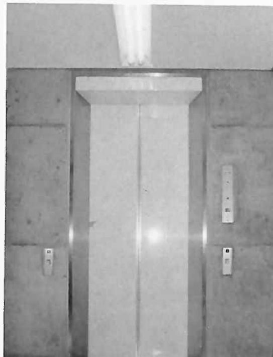
エレベーター ▶
